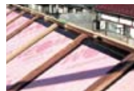
[屋根] 超高性能断熱材 66mm
